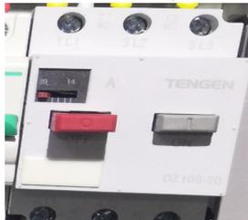
4. Проверьте срабатывание защиты. При частом отключении превышен ток или неисправна защита (рис.9.8) Ток 20А
