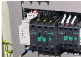
2. Проверьте исправность контактора привода отрезного механизма (рис.9.6).
